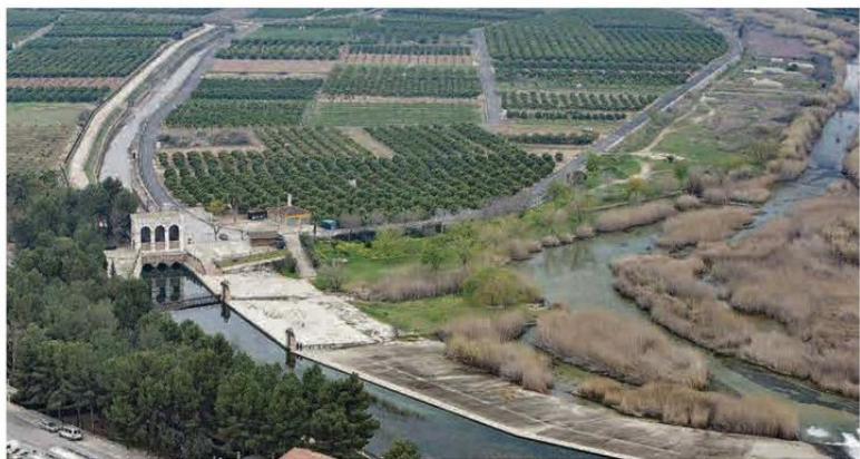
Vista aérea de l'Assut de Antella con el nacimiento de la Séquia Reial del Xúquer a la izquierda y el caudal del río a la derecha.
